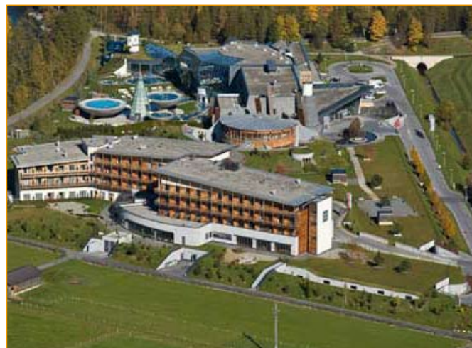
Veduta aerea di uno dei agglomerati alberghieri
